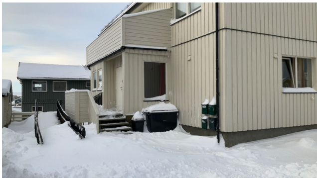
utvendige trapper adkomst 1. etasje
