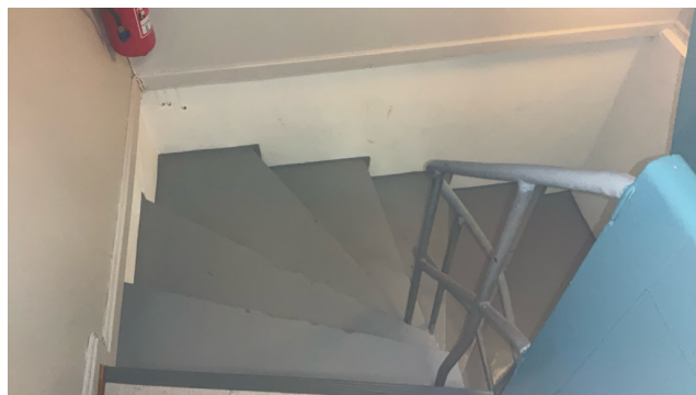
betongtrapp mellom etasjer
