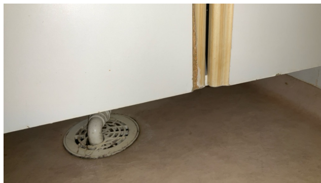
fuktskade skrog
