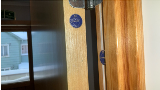
B30 dør inn til leilighet 2. etasje
