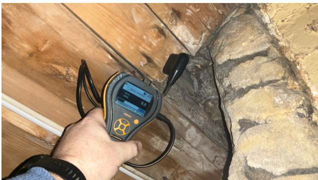
fuktsøk i fuktskjolder på nedsiden av pipen, ikke funnet unormale verdier
