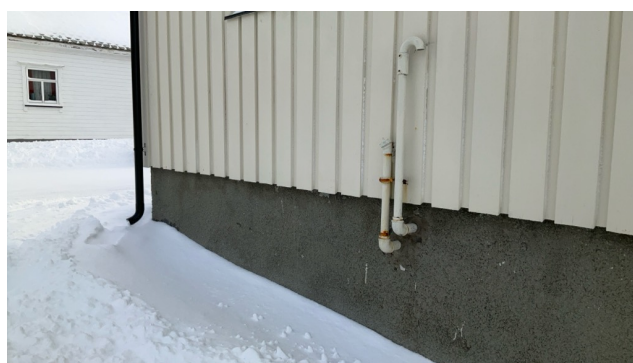
avløfting oljetanker
