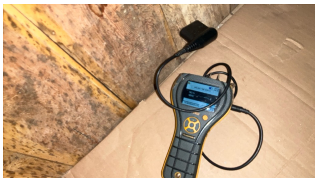
fuktsøk inn mot dusjsone, ikke funnet forhøyde fuktverdier
