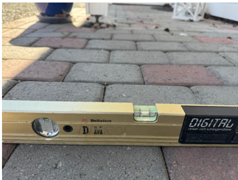
Belegningsstein med svakt fall vekk ut bygningskropp
