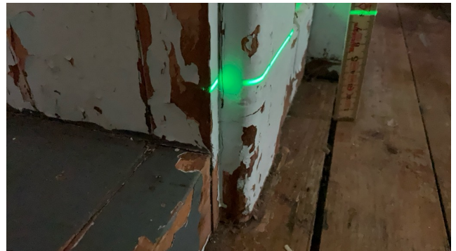
4 meter fra laserpunkt , 40mm høydeavvik
