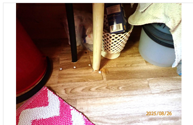
Rørgjennomføringer i gulv.
