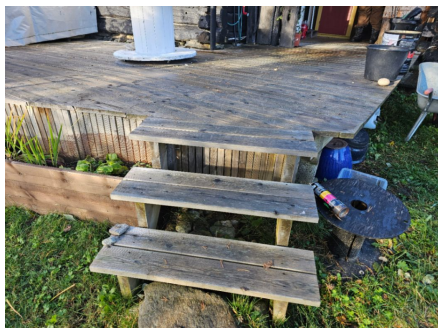
Manglende rekkverk.
