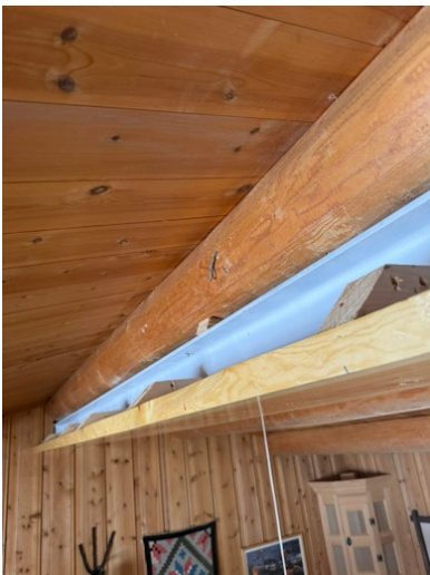
Forsterkning av møneås i stue.
