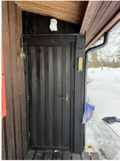
Ytterdør til terrassen
