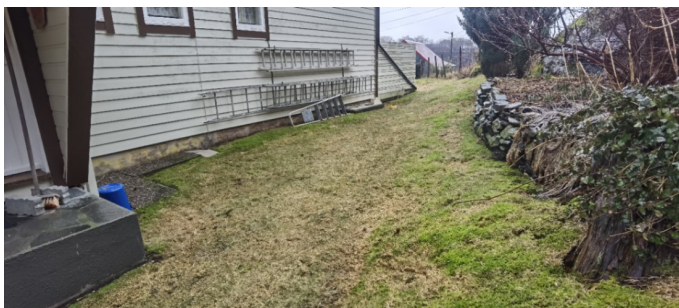
Terreng nord for huset
