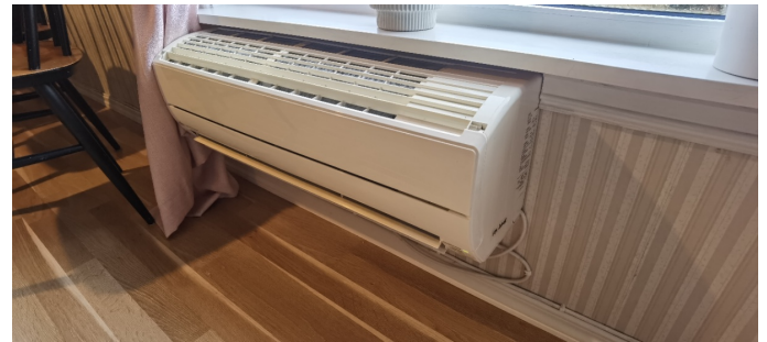
Innvendig del av varmepumpe
