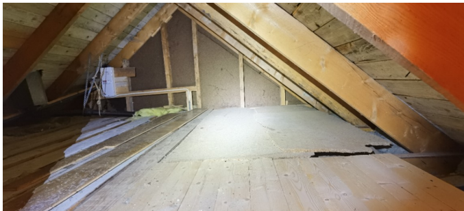
Kaldloft i opphavleg del av bygningen
