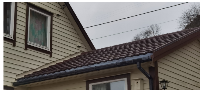
Takfall sør ved tilbygg
