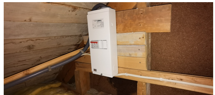
Hovudinntak på kaldloft
