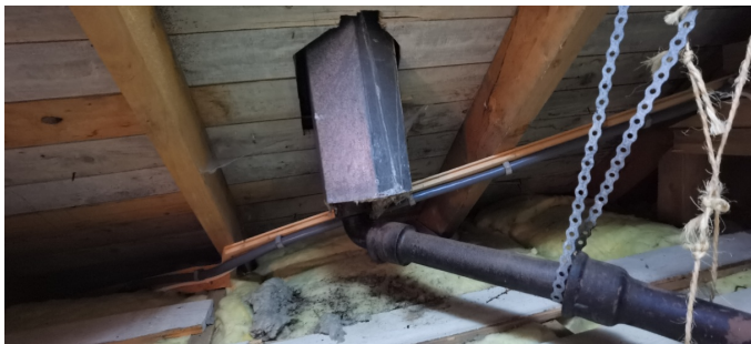
Lufting ført over tak
