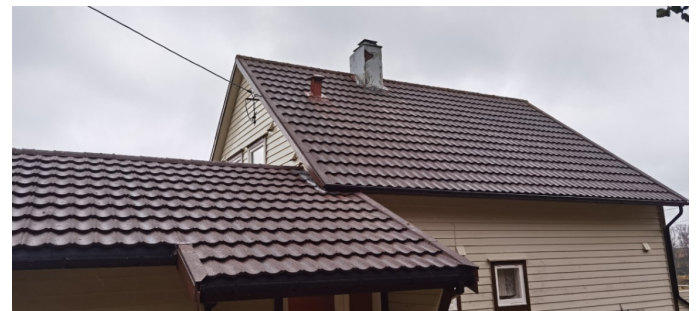
Takfall mot nord
