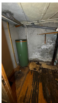
Bereder plassert i bod. Rom uten sluk
