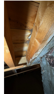
Fuktskjolder i området ved gjennomføring pipe
