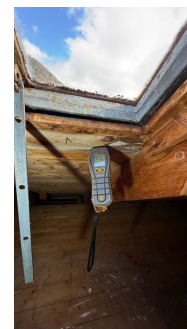
Fuktskjolder i området ved gjennomføring pipe
