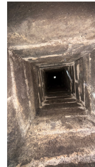
Innvendig pipe, sett fra sotluke underetasje
