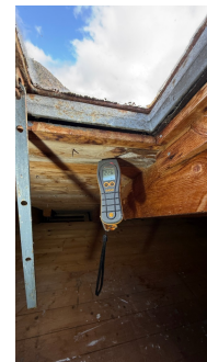
Fuktskjolder i området ved gjennomføring pipe
