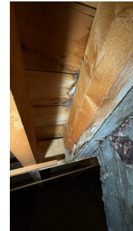
Fuktskjolder i området ved gjennomføring pipe
