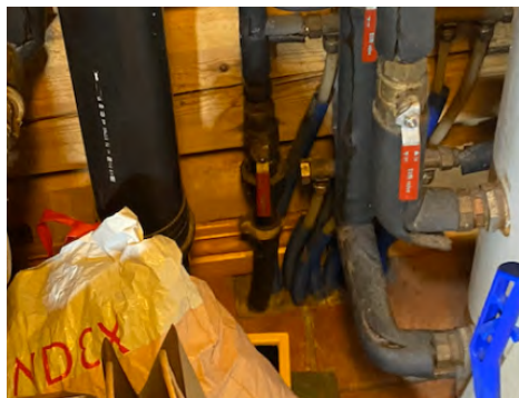
Stoppekrane plassert på tekniskrom.
