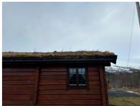
Påbegynt fuktskader vindski -bord.
