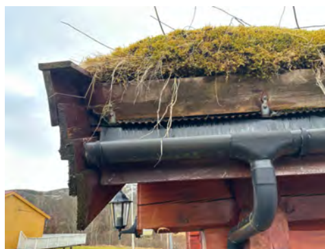
Påbegynt fuktskader vindski -bord.
