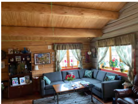
Skjevheter i takkonstruksjon.
