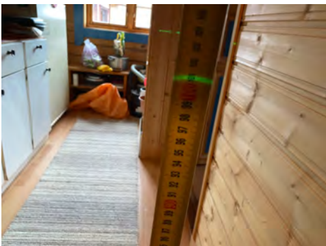
Måling av planavvik
