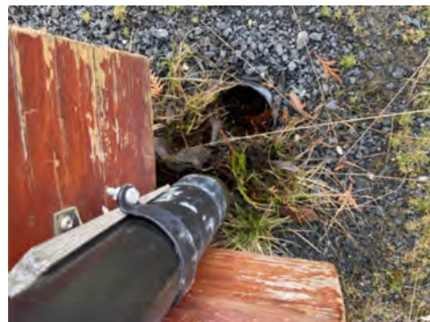
Manglende tilkobling av nedløpsrør til grunn.
