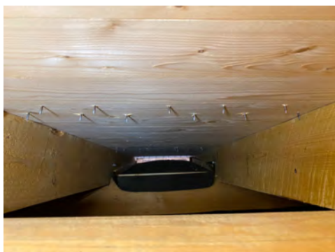
Lufting ut over raft.
