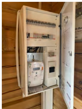
Sikringsskap med automatsikringer.
