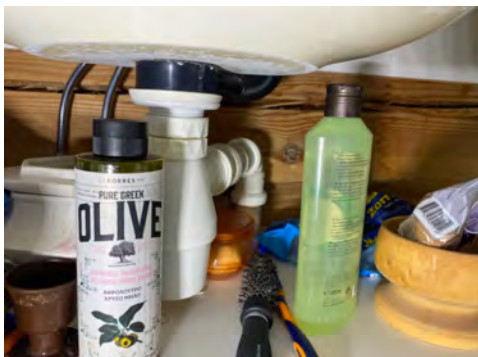
Kontroll av røropplegget.
