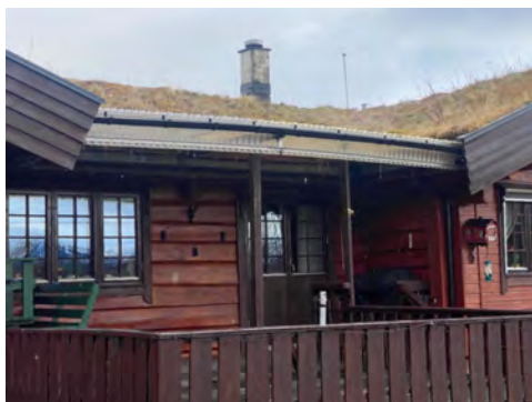
Tak over terrasse.
