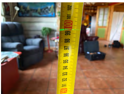
Måling av planavvik
