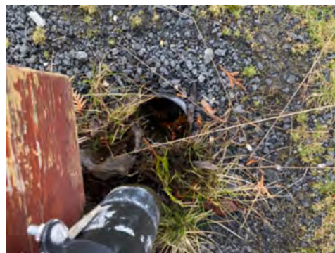
Nedløpsrør for drenering i grunn
