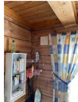
Vegger består av åpen tømmerkonstruksjon.
