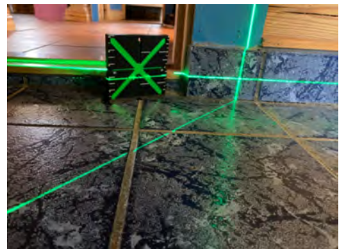
Måling av fallforhold fra dør.
