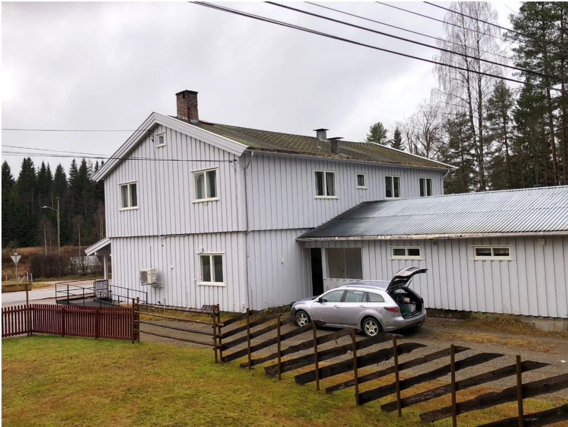
Foto 2: Bygget sett fra haugen sør-øst for bygg.
