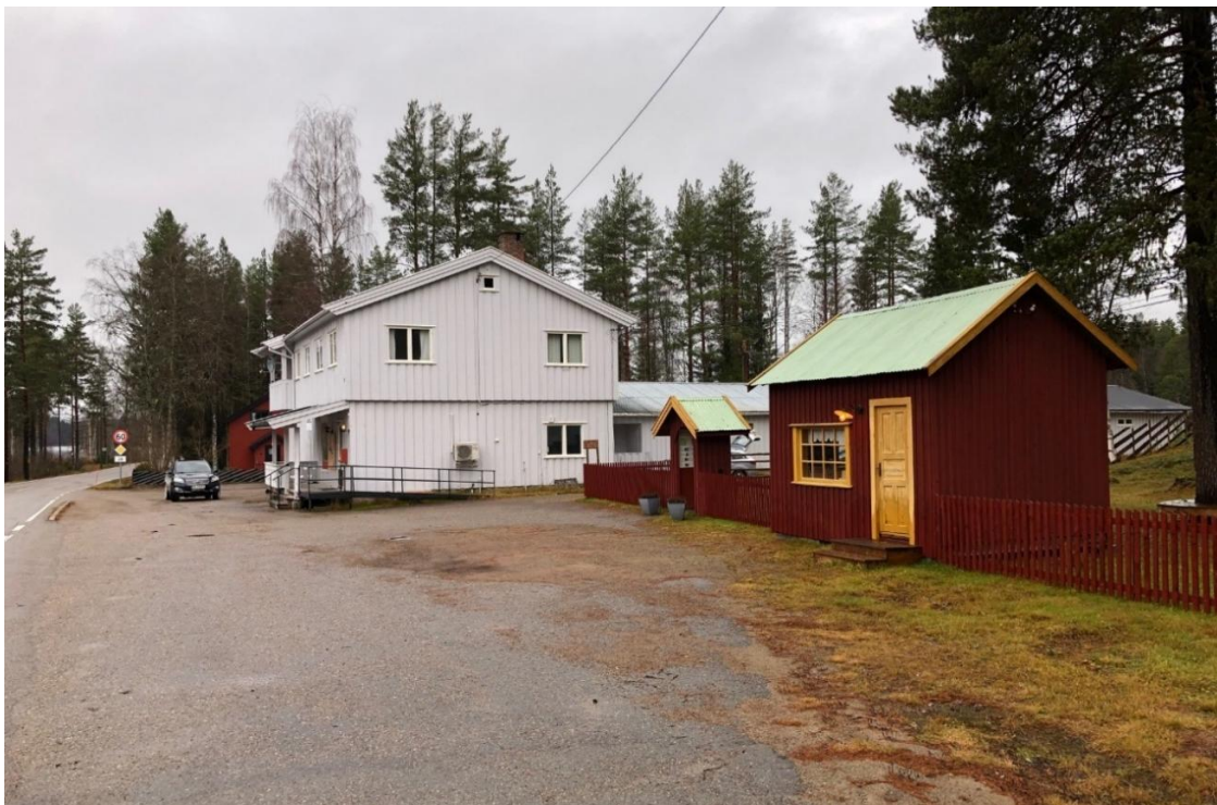
Foto 1: Bygget sett fra sør langs FV26 med Svenskebua th i foto.
