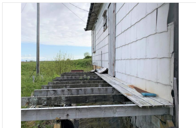
Vegg mot sør-øst
