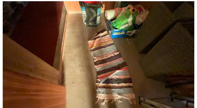
Betonggulv i sportsbod
