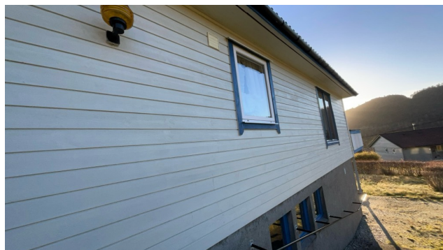
Pvc vindu på kjøkken
