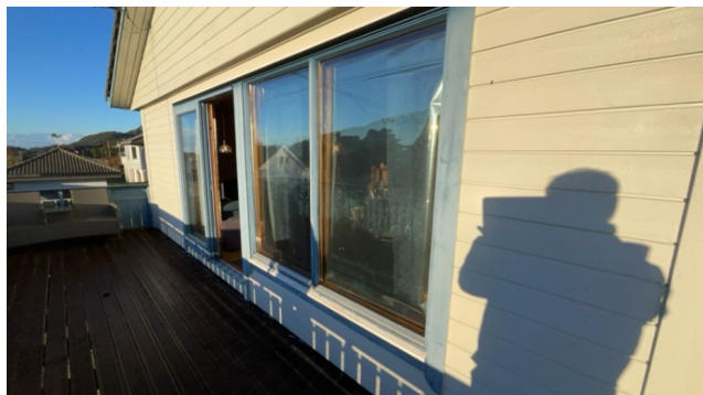
Vinduer i stue
