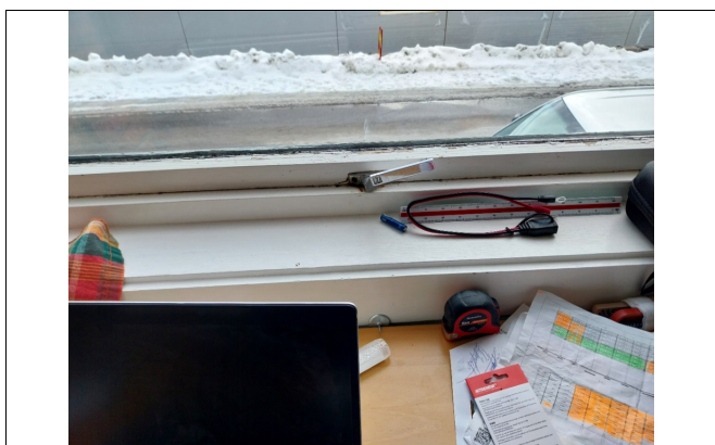
1.etg; slitt vindu
