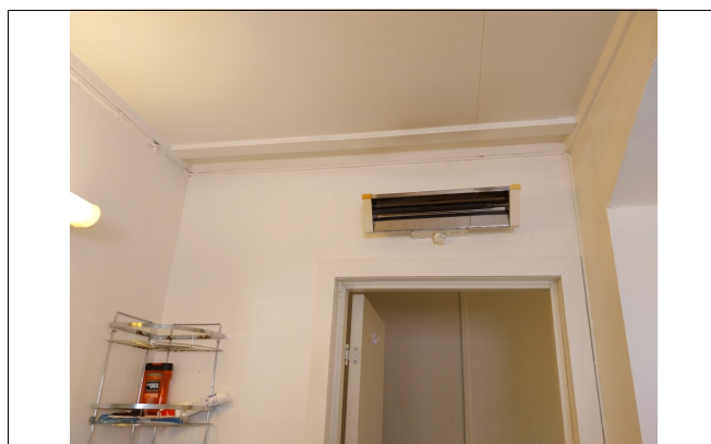
1.etg; bad / Wc / vaskerom
