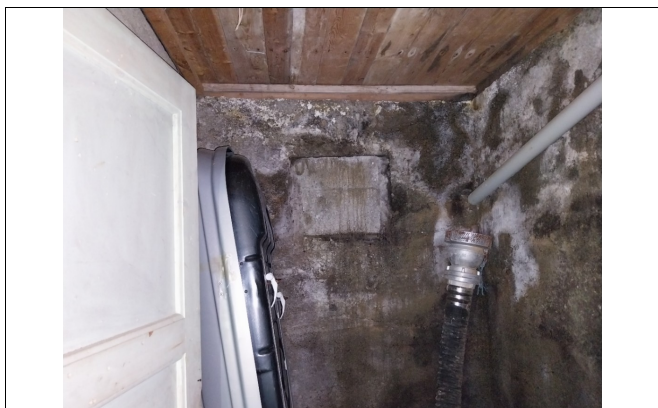
Kjeller; rom under yttergang
