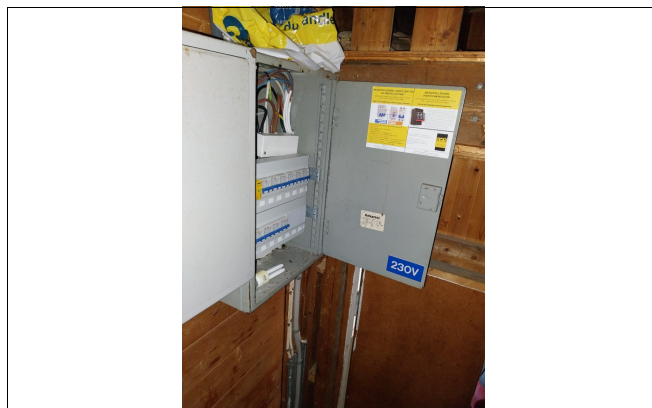
Loftsgang; Sikringskap
