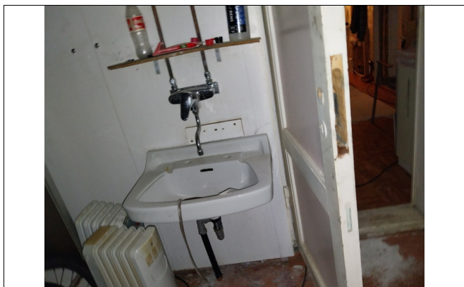
Kjeller; Bad / dusj / vaskerom
