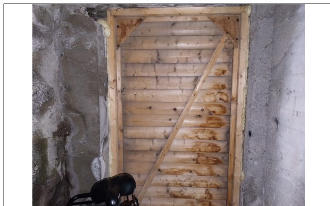
Kjeller; rom m / ytterdør under yttergang
