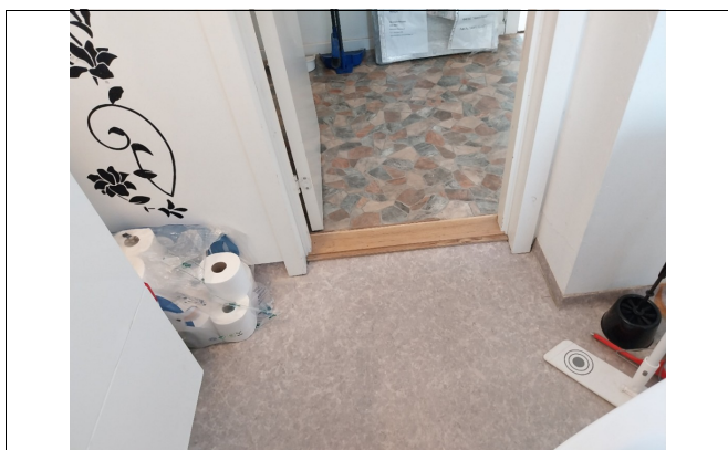
1.etg; bad / Wc / vaskerom
