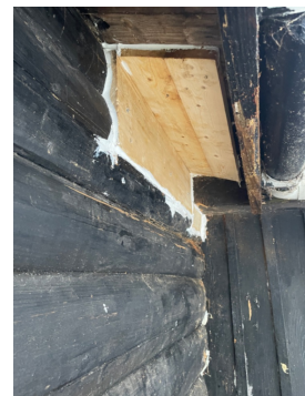
Etter utbedring gjort av eier etter befaring
