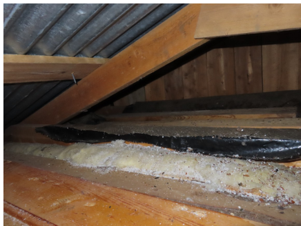
Stålplater/bølgeblekkplater fra byggeår.
