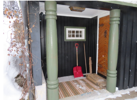
Hovedytterdør som utadslående fra vindfang til overbygd inngangsparti. Dør fra byggeår med utv. trepanel i fiskebeinsmønster.
