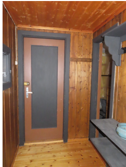
Hoveddør som speildør (redusert isolasjonsverdi).
