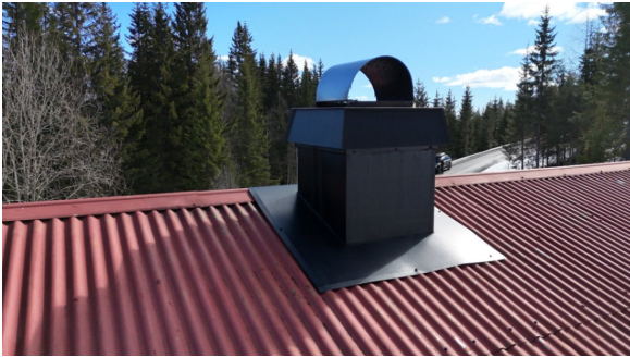
Pipe over tak som helbeslått. Nytt beslag de senere år av dagens eier.
