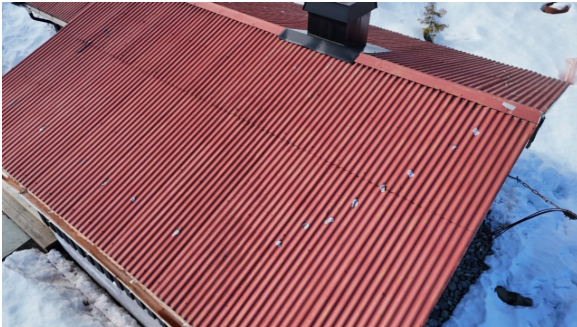
Stålplater/bølgeblekkplater fra byggeår.
