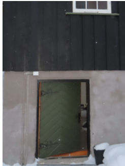
Dør til kjeller som innadslående. Speildør med utv. trepanel.
