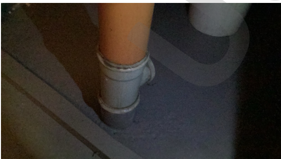
Stakepunkt i kjeller.
