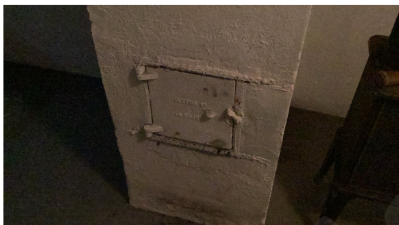
Sotluke i kjeller.
