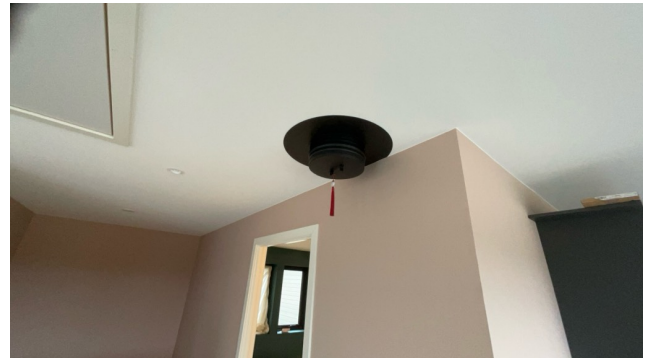
Stålpipe avsluttet i himling.
