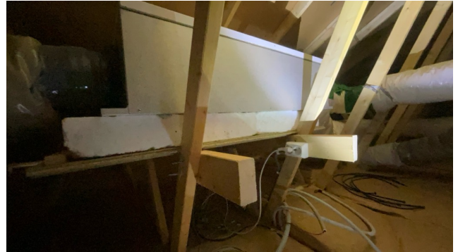
Enhet for balansert ventilasjon.
