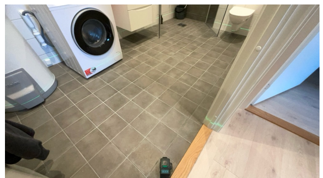
Måling av fall til sluk
