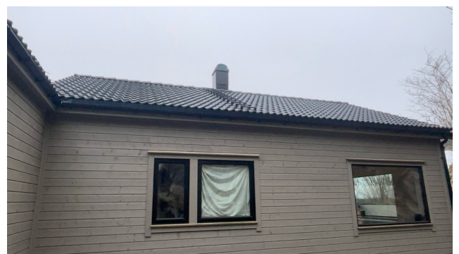
Montert stigetrinn til pipe.
