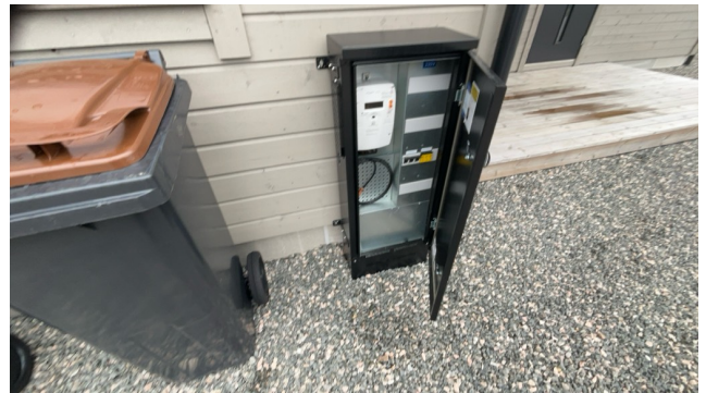
Utvendig sikringskap
