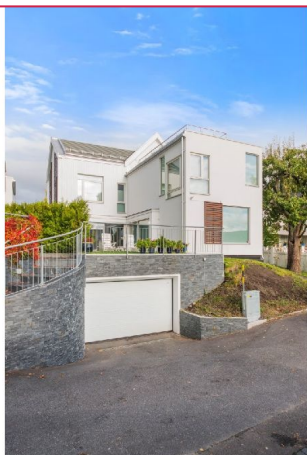
Inngang via fellesgarasje
