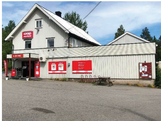
Bilde nr. 2 Bygning sett fra sydøst.
