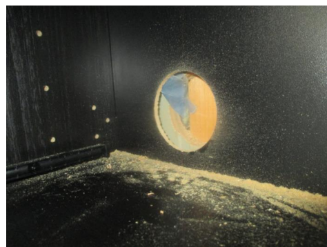
Hulltaking i fra kjøkkeninnredningen.
