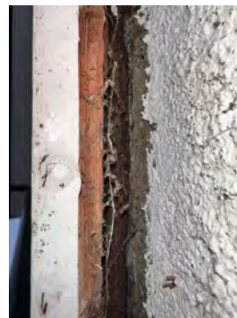
Lite til ingen lufting bak kledning.
