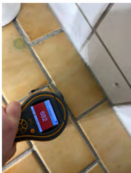
Fuktmåling av overflate på bad.
