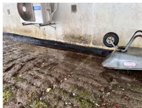
Fuktsikring mot mur.
