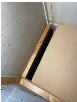
Veggplate over himling mot nabo.
