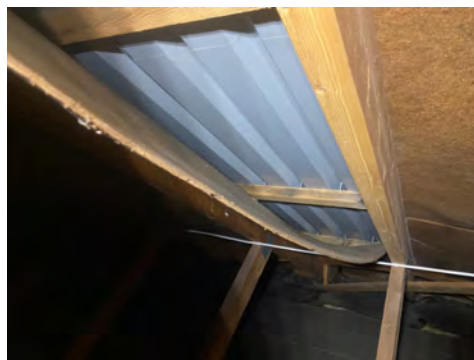
SU- plater/undertak som har løsnet fra taksperre.
