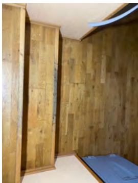
Mangler avslutning på spilevegg som fungerer som rekkverk.
