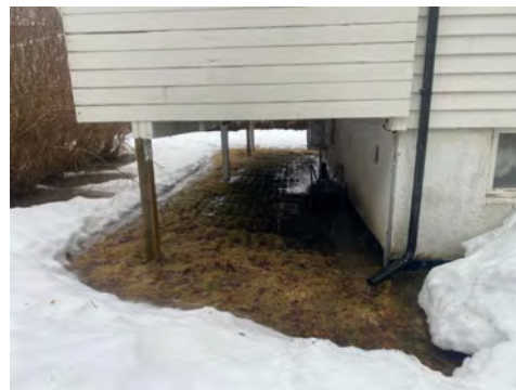
Nedløp avsluttet mot mark ved mur.
