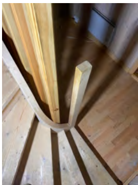
Mangler avslutning på spilevegg som fungerer som rekkverk.
