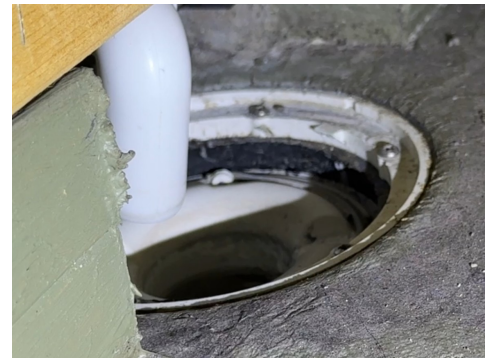
Sluk bak vaskemaskin
