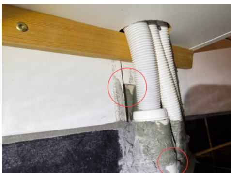
Røde ringer visre manglende membran
