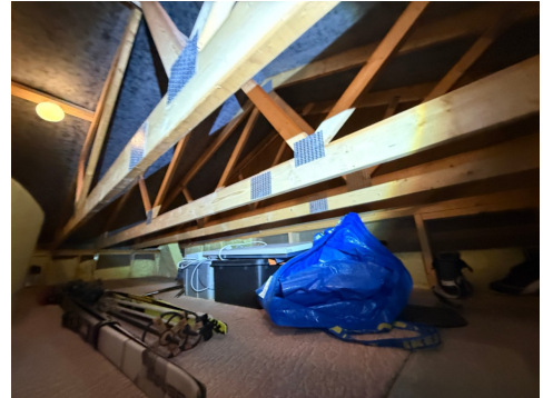
Loft over tilbygget
