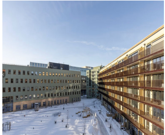
Gårdsrom og fasade — Ulvenplassen
