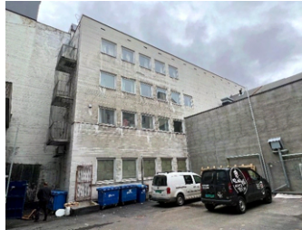
Fasade nord (mot bakgården)
