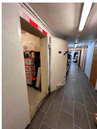
Dør til tilfluktsrom
