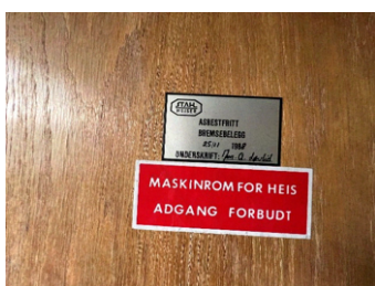
Heismaskinrom i 5. et
