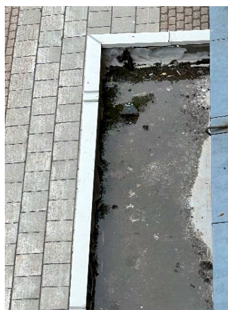
Baldakin mot nord i Storgata
