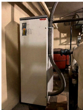
Elektrisk varmekolbe erstatter i dag oljefyrte ovner fra byggeår
