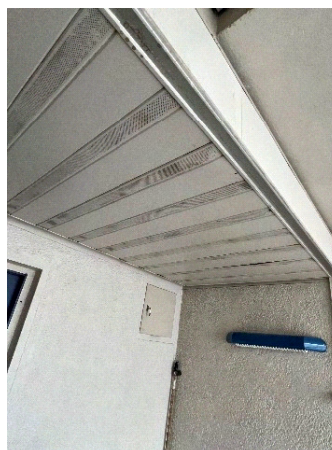
Trapperom utenfor heis og inngang til etasjene
