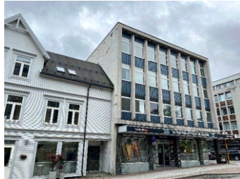
Fasader vest og del av fasade nord mot Storgata 1.
