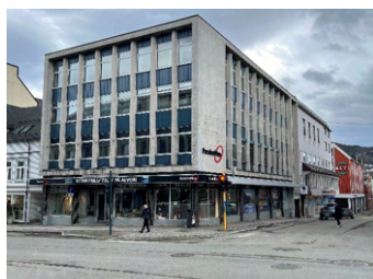
Fasader mot sør og vest. Mot Hvedingsgate og Storgata.
