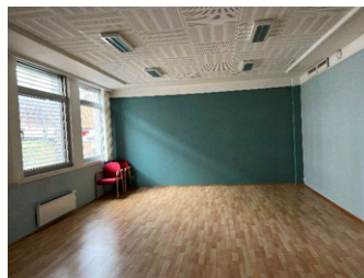
Eldre lysarmaturer som må kontrolleres for PCB.
