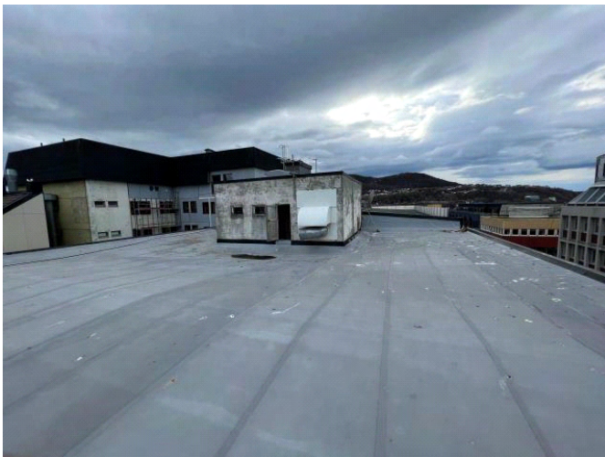
Oppbygd teknisk rom på tak (5. et)
