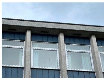
Luftet takkonstruksjon. Ventilert over vindusfelt i 4. et.
