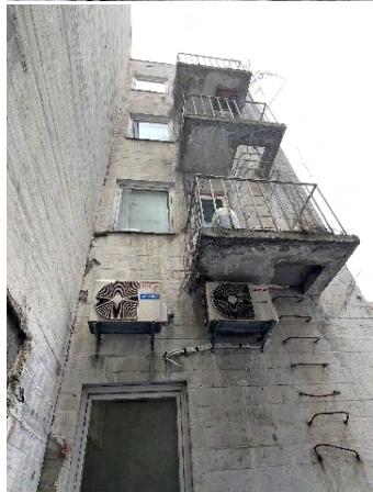
Fasade øst (mot bakgården), med nødutganger fra etasjene.
