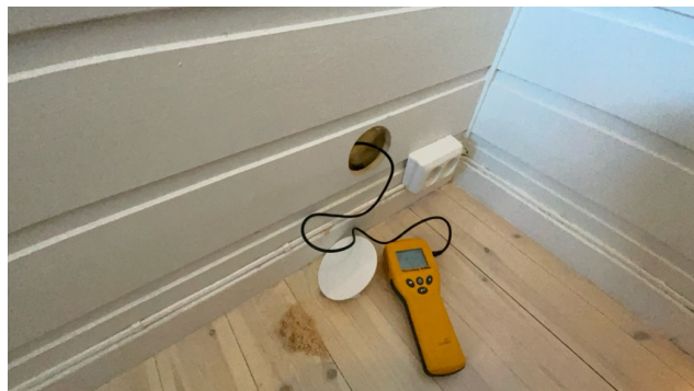
Fuktkontroll i vegg mot gang/ stue.
