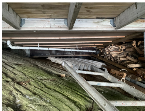
Avløpsrør fra kjøkken.
