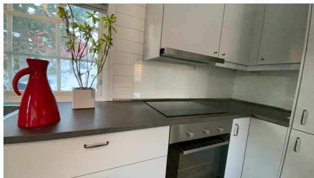
Avtrekksvifte over komfyr.
