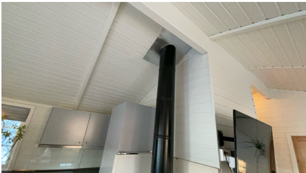
Pipe: gjennomføring i tak
