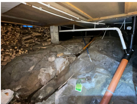
Krypkjeller opprinnelig bygg.
