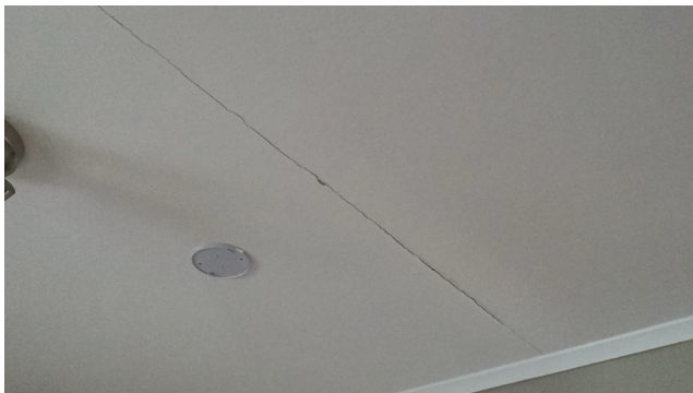
Himling på soverom 1 etasje
