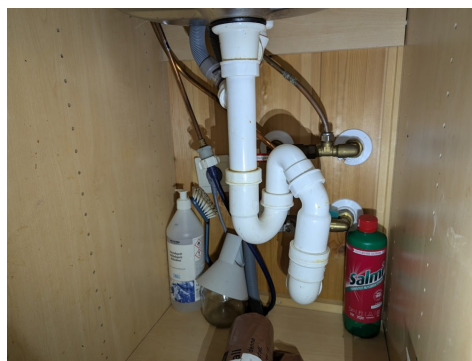
Avløpsrør i kjøkkenbenk
