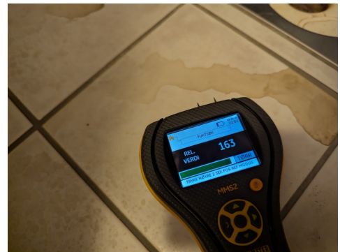
Fuktsøk uten unormale fuktutslag på gulv
