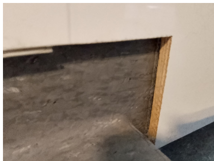
Uferdig montering i nedkant av veggplater
