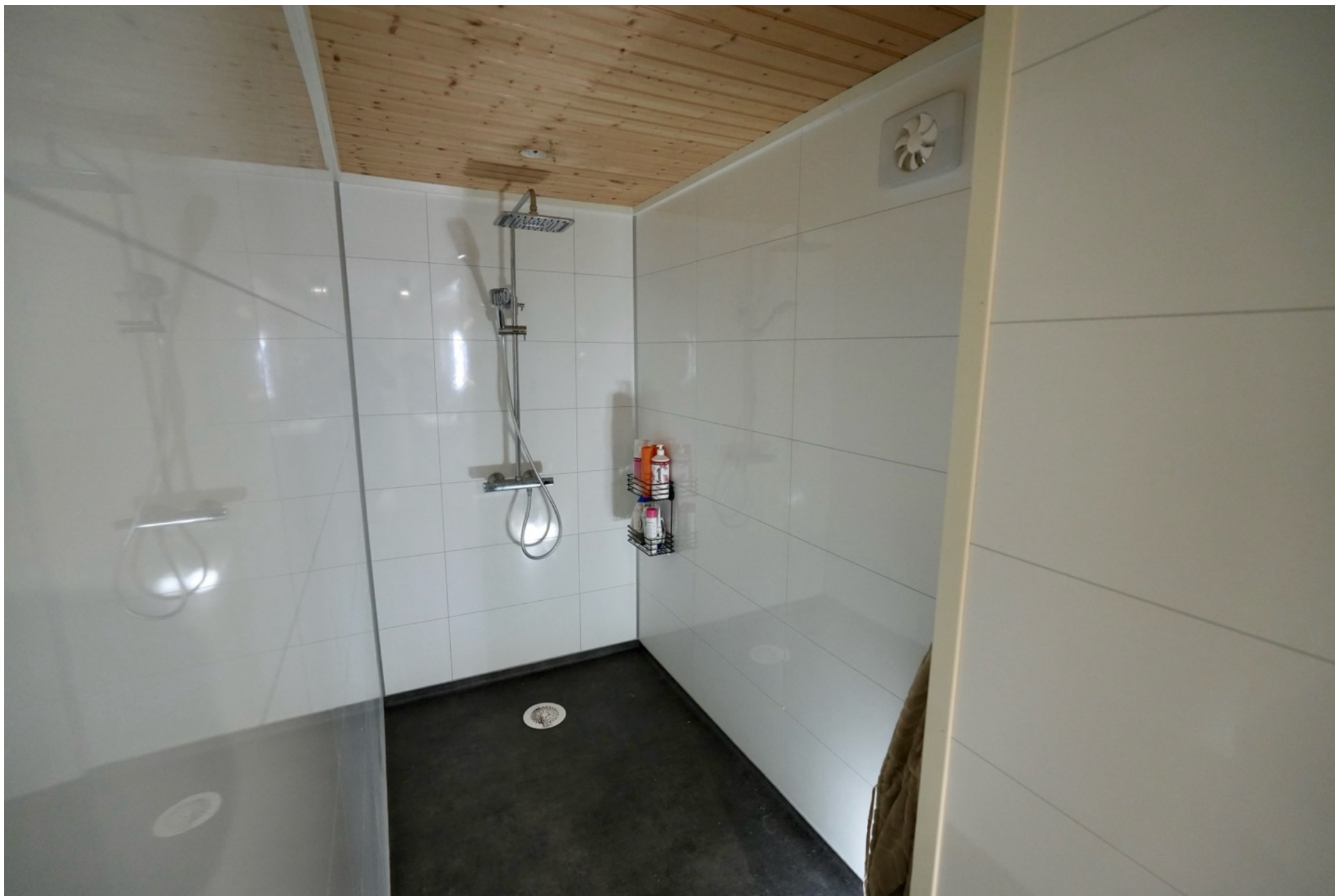
Enorm dusj med fuktregistrerende baderomsvifte
