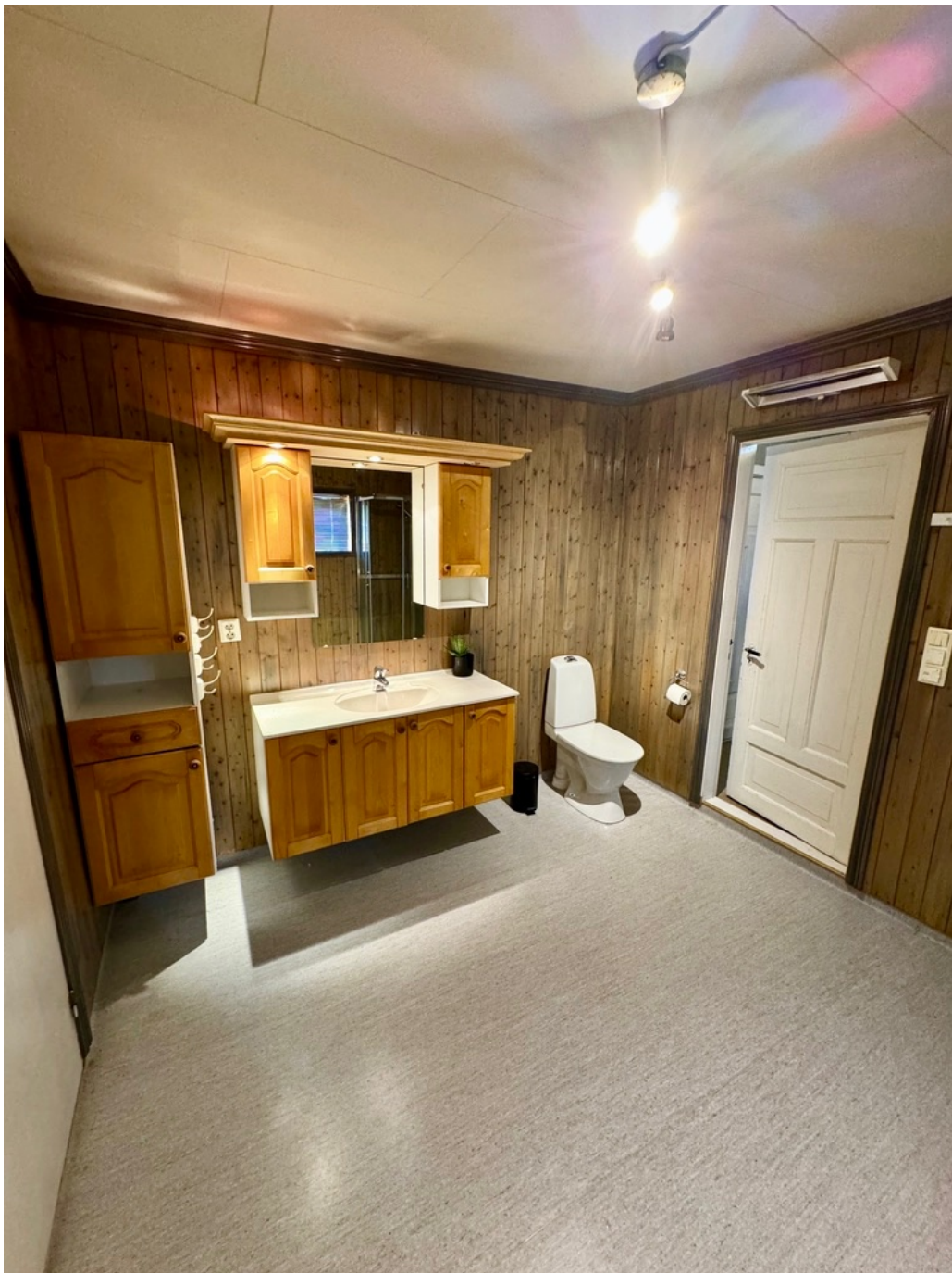
Bad 2.etasje med beiset trepanel på vegger og vinylbelegg på gulvet
