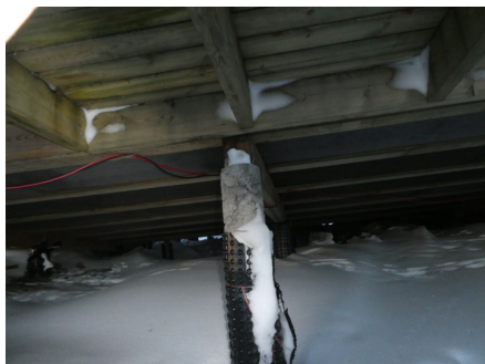
Søylar under tilbygg
