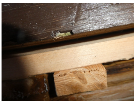
Ingen synlig muse sperre. Bildet er fra siden til inngangsdøren.
