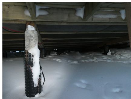
Søylar under tilbygg
