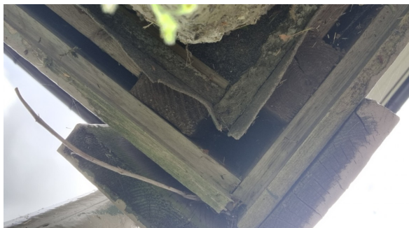
Kontroll av ytterkledningen og bakenforliggende lekter og vindsperre.
