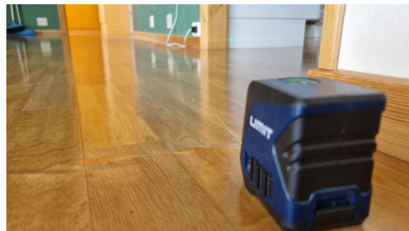
Kontroll av planavvik og skjevheter med krysslaser, her fra stue og dels inn mot kjøkken.
