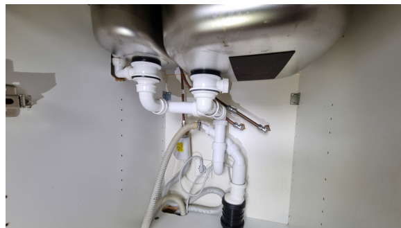
Kontroll av røropplegg under oppvaskkummen.
