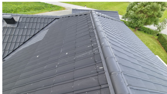
Visuell besiktelse av taket.
