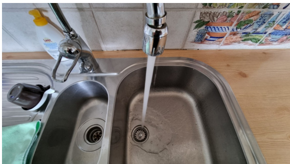
Kontroll av vanntrykk og avrenning.
