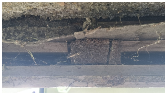
Kontroll av luftingen bak kledningen.
