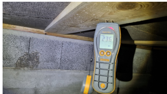
Fuktmåling i stubbloft
