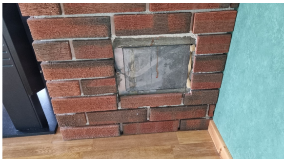
Kontroll av sotluken.
