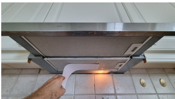
Funksjonstesting av det mekaniske avtrekket over komfyren.
