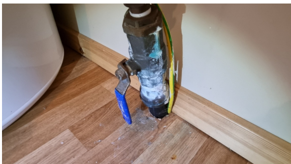
Kontroll av innvendig hovedstoppekran.
