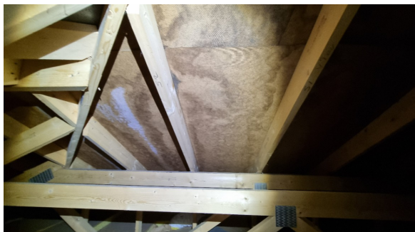
Inspeksjon av kaldloftet.
