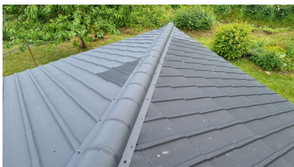
Visuell besiktelse av taket.
