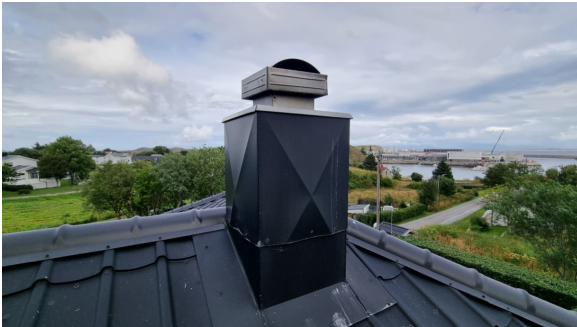
Kontroll av pipebeslag.
