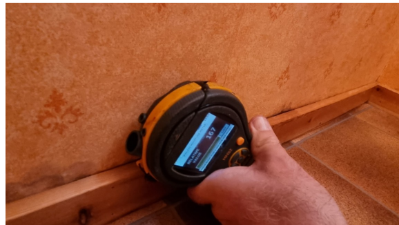
Fuktmåling i vegg med fuktmerker.
