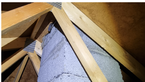
Kontroll av pipen på kaldloftet.
