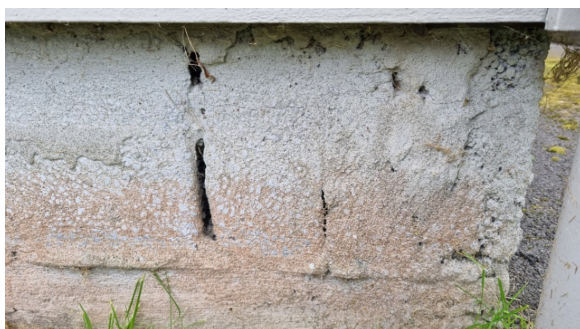
Utettheter mellom lettklinkerblokker.
