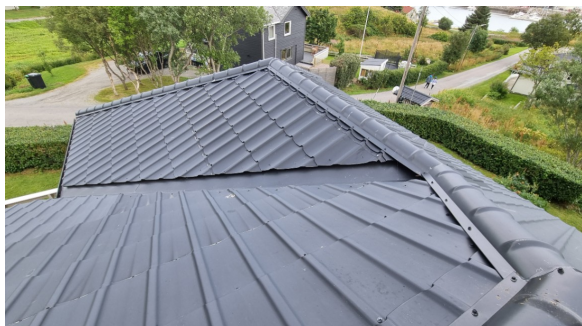
Visuell besiktelse av taket.
