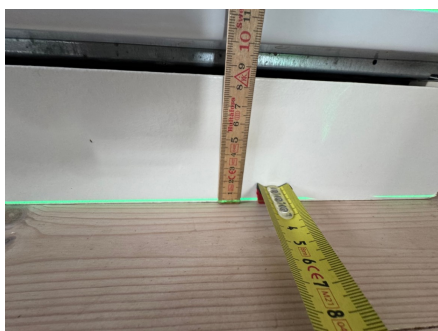
Måling ved kjøkkenet.
