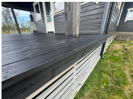
Det er ikke montert rekkverk på altanen.
