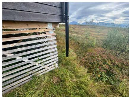
Takrennenedløp er avsluttet ved søyle.
