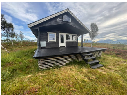
Det er ikke montert rekkverk på altanen.
