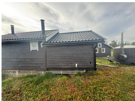
Det er ikke montert takstiger til pipene.
