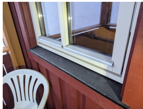
Utvendig vannbrett / vindusomramming
