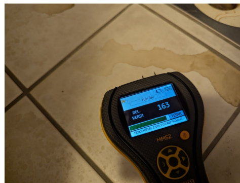
Fuktsøk uten unormale fuktutslag på gulv
