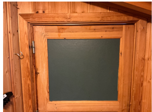
Lysglimt over dør, skjevhet.
