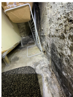
Synlig saltinnslag ved trapp til kjeller.
