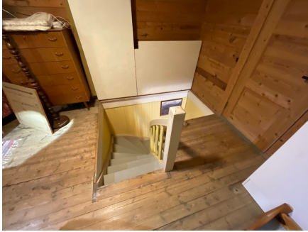
Det mangler gelender rundt trappeåpning på loftsplan.
