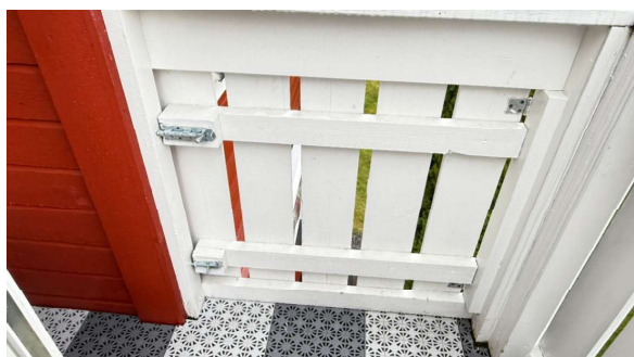
Luke i verandarekkverk.
