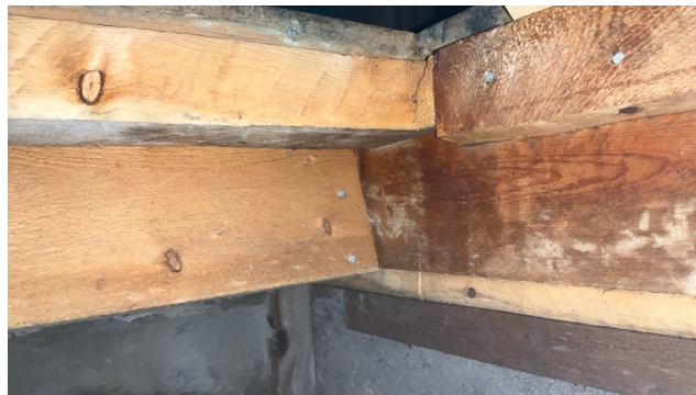
bjelkelag sett fra kjellerrom (matbod)
