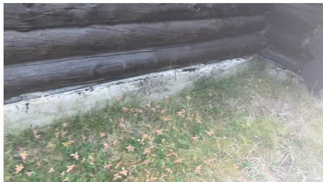
grunnmur av betong
