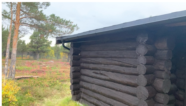
takrenner og nedløp av sort stål.
