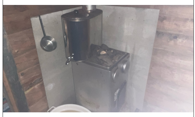
vedfyrtd badstueovn med varmtvannstank
