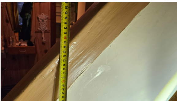
Kontroll av rekkverkshøyde.
