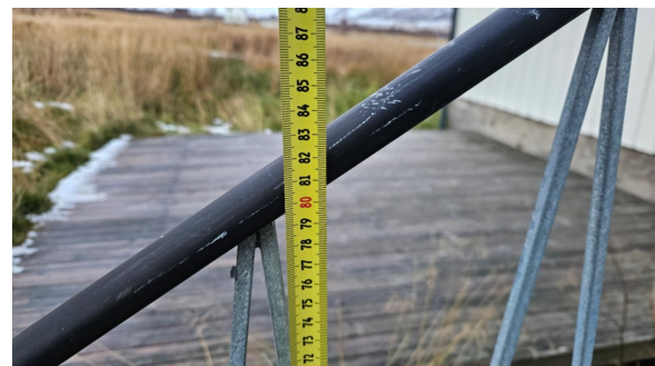
Kontroll av rekkverkshøyde.
