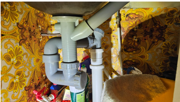
Kontroll av røropplegg.
