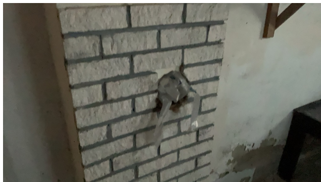
Røykrørsinnføring midlertidig tettet med plast i kjeller.
