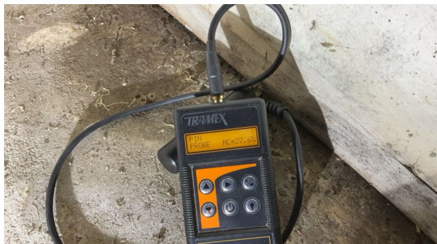
Eksempel på registrert fukt.
