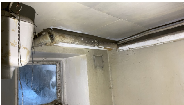
Deler av røranlegget er demontert/blindet.
