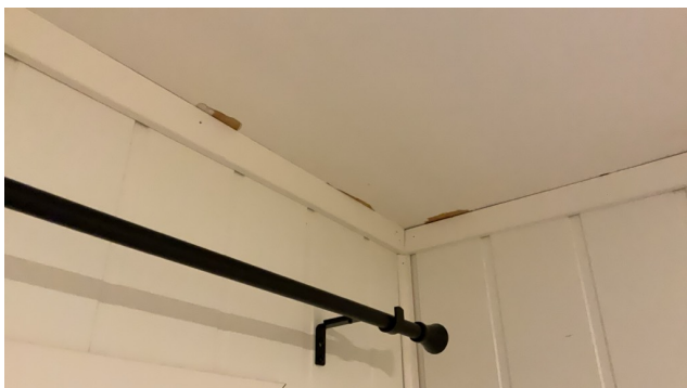
Eksempel på skade etter tidligere lister.
