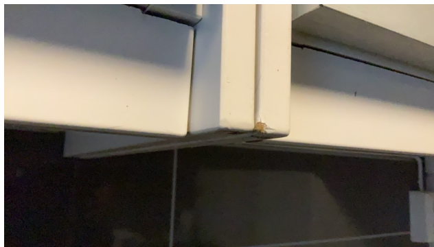
Eksempel på skade.
