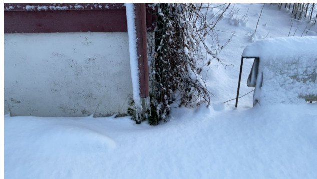
Eksempel på manglende bortledning av vann fra taknedløp.
