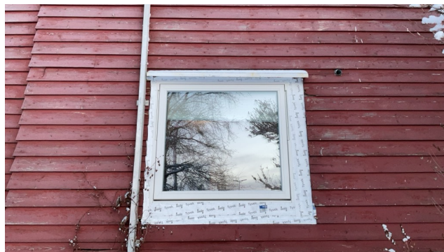
Eksempel på manglende beslagsløsning under vindu.
