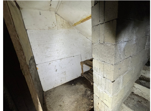
Eksempel på synlig isopor.
