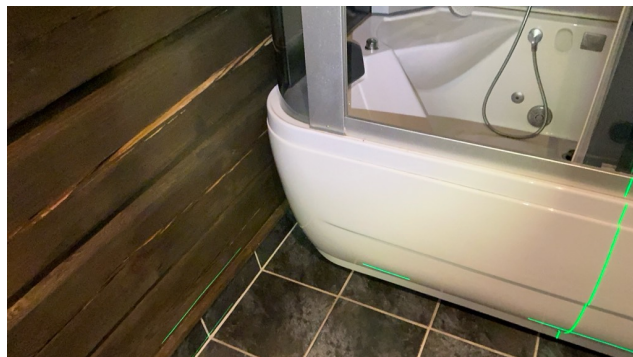
Vegger i våtzone
