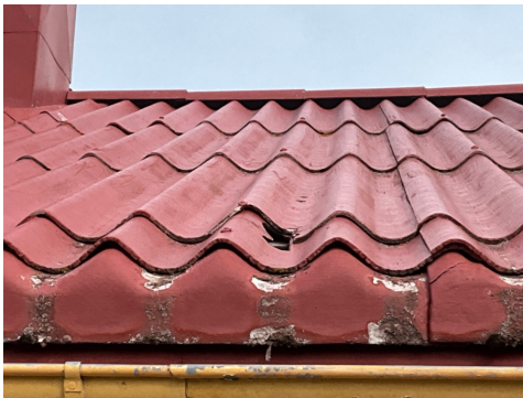
Knekt takplate på sørlig side
