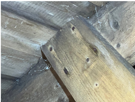
Rustede spikre i konstruksjonen
