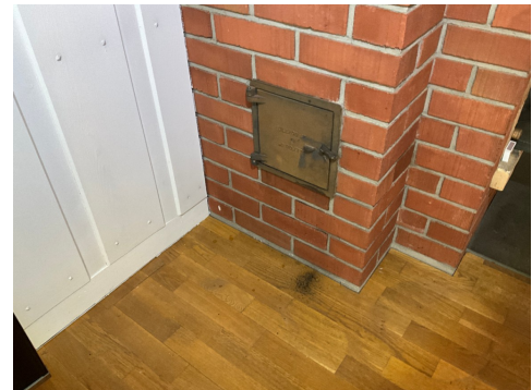
Sotluke i tilbygget
