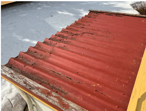
Taket sett 1. etasje
