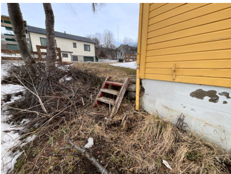
Forstøtningsmur langs innkjørsel til garasjen
