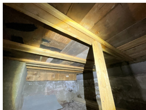
Provisorisk understøttelse av etasjeskiller
