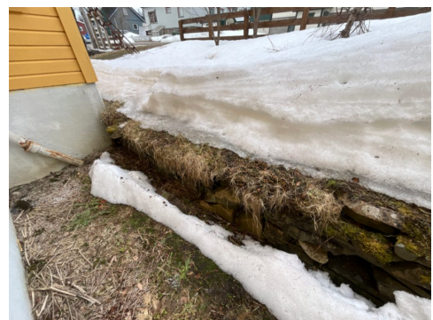
Fall mot grunnmuren
