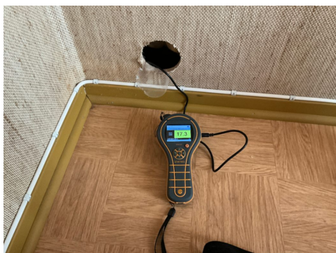
Fuktmåling i innforet vegg mot grunnmur
