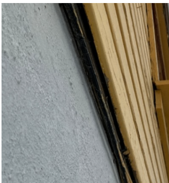
Ikke påvist lufting i nederkant av kledningen
