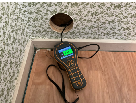
Fuktmåling i tilliggende konstruksjoner
