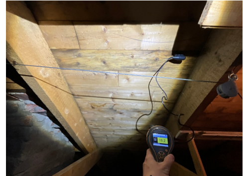
Fuktmåling i undertak over garasjen
