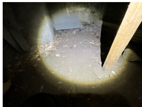
Mangler fuktsperre
