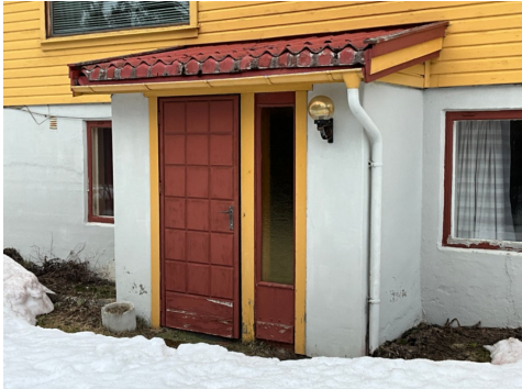
Inngang til underetasjen
