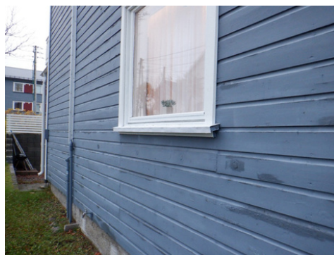
Utvendig bordkledning.
