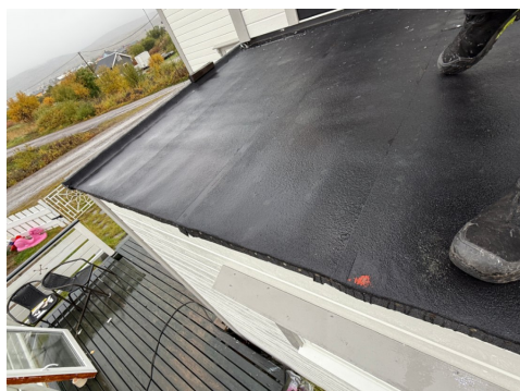
Tekking over inngangspartiet
