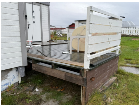
Rekkverk mangler
