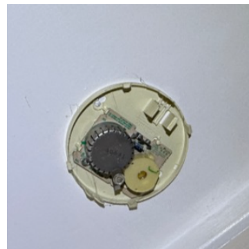
Mangler røykvarsler på loftet
