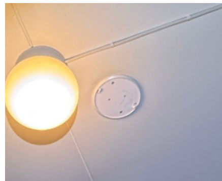
Mangler røykvarsler på loftet
