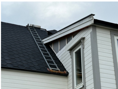
Mangler bordkledning
