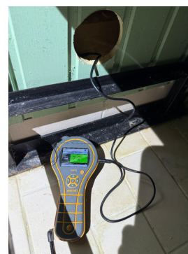
Fuktmåling i tilliggende konstruksjon
