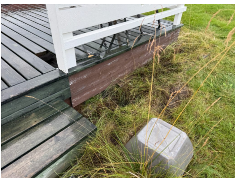
Kledningsbord ned mot terreng
