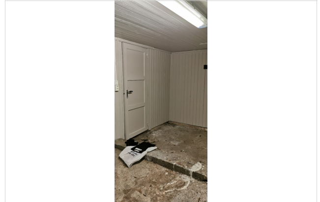
Del av fellesrommet i kjelleren.
