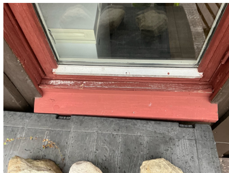
Blekk slått på ytersiden av karm
