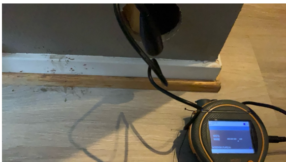
Fuktmåling i konstruksjon mot bad.
