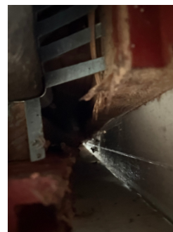
Stikkprøver viser åpninger i musebånd på hjørne
