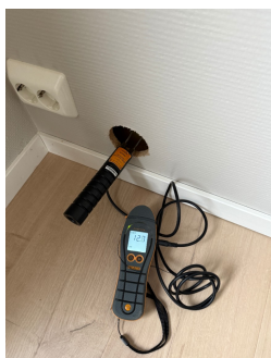
Fuktmåling fra stue mot dusjsjonen
