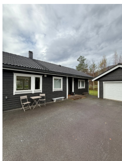
Manglende snøfanger ved inngangsparti
