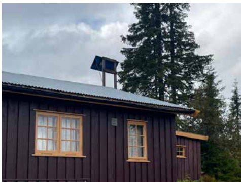
Deformasjoner i takrenner og manglende snøfangere ved gangsoner
