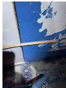
For liten avstand til brennbart materiale.
