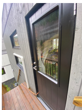
Balkongdør med utgang til trapp.
