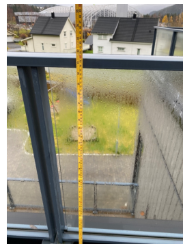
Rekkverkshøyde målt fra beslag er 80 cm.
