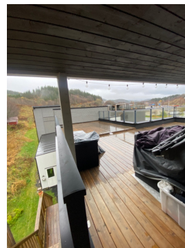
Rekkverkshøyde målt fra beslag er 80 cm.
