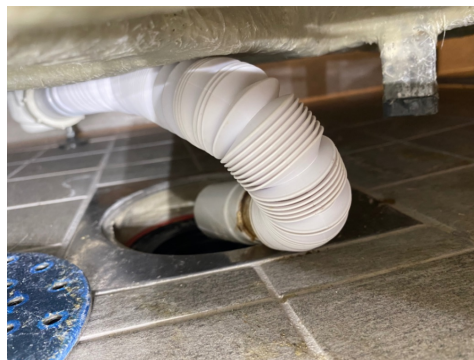
Sluket har begrenset tilkomst under dusjkabinett.
